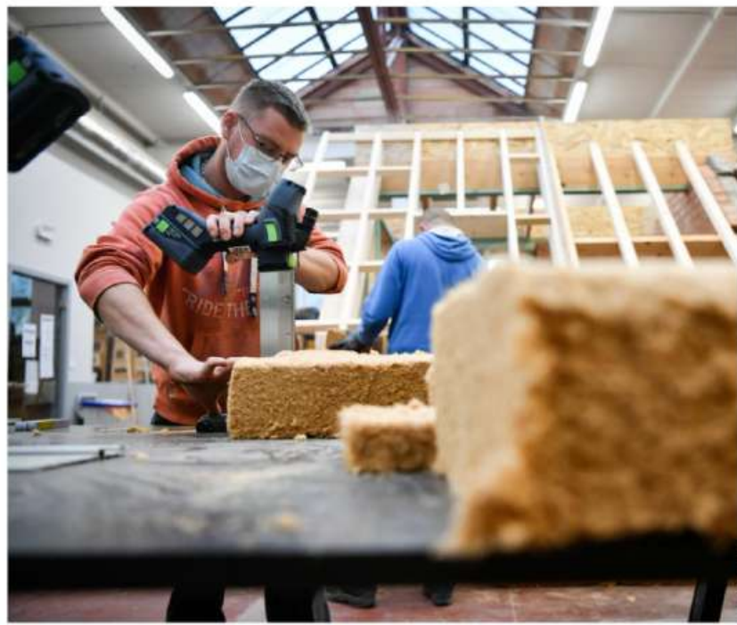
Isoler : un chantier gigantesque... toujours à organiser.
